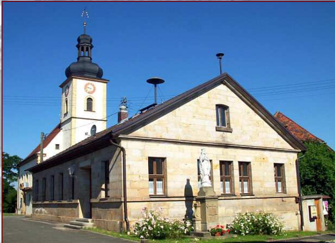
Die „Alte Schule“ in Lohr, wunderschön restauriert
